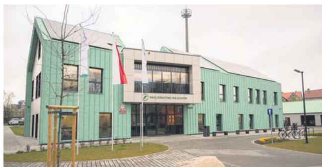
Budynek biurowy Nadleśnictwa Sulechów
