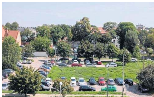
Przebudowana ma być ulica Bernardyńska i parking przed Radomskim Szpitalem Specjalistycznym.
