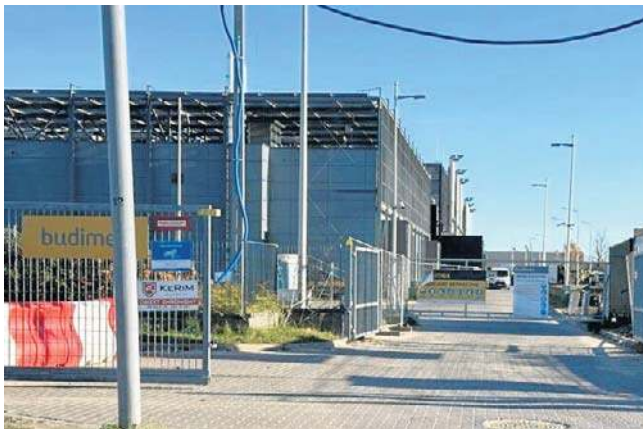
Tak w listopadzie wyglądał stan rozbudowy Centrum Informatyki Resortu Finansów w Radomiu.
