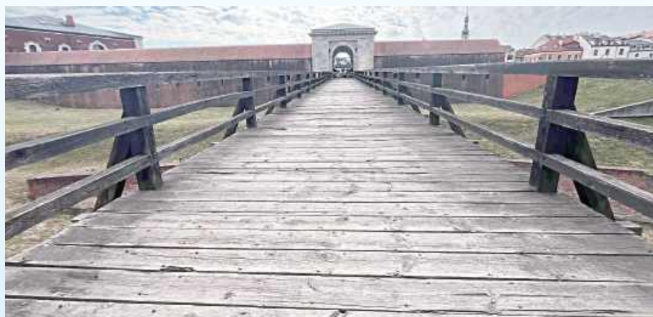
Drewniany most przy Nowej Bramie Lubelskiej został zamknięty wiele lat temu
