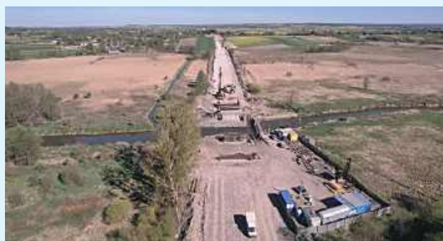
Powstający obiekt będzie miał około 71 metrów długości i zastąpi dotychczasowy most
