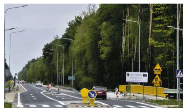
Drogowcy mają zakończyć prace już 30 maja
