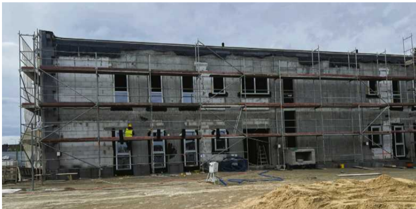
Budowa przedszkola w Wilczopolu
