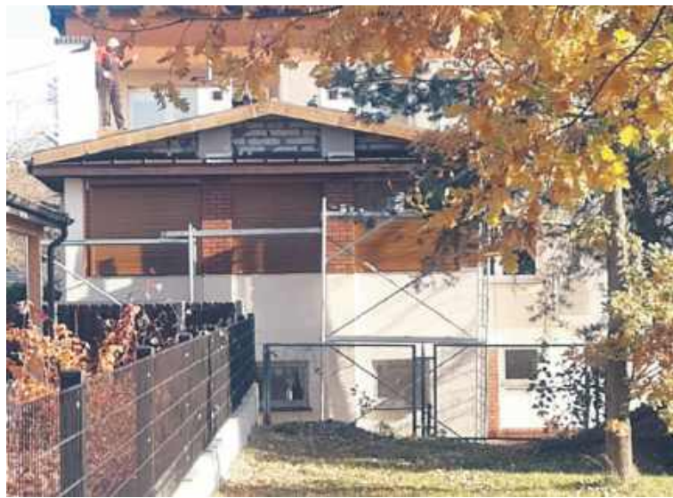
Taras w trakcie budowy
