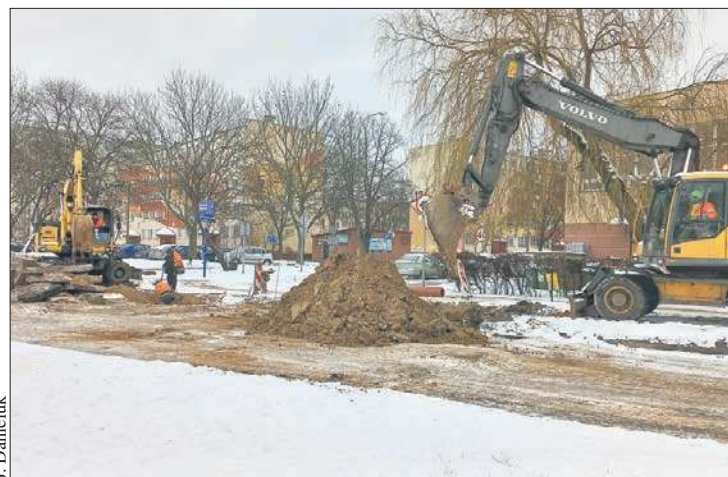
Prace na skrzyżowaniu ulicy Batalionów Chłopskich z ulicą Zgliczyńskiego
