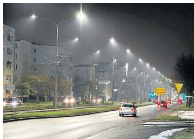
Miasto inwestuje w nowoczesne oświetlenie w kilkunastu lokalizacjach
