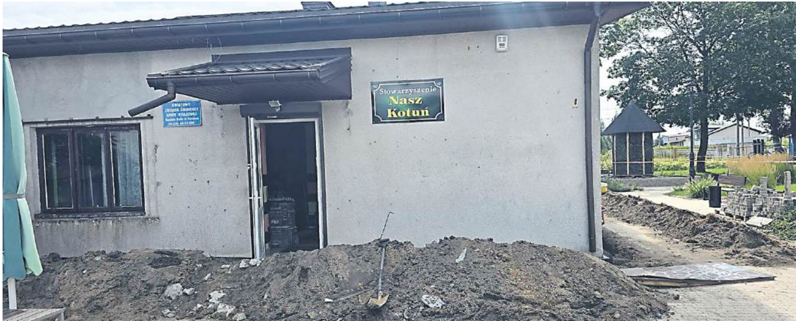
Budynek otrzymuje szansę na kolejny etap swojej historii.
