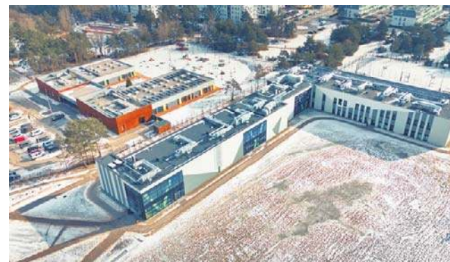
Postępowanie na realizację drugiego etapu budowy jest prowadzone w formule „zaprojektuj i wybuduj”
