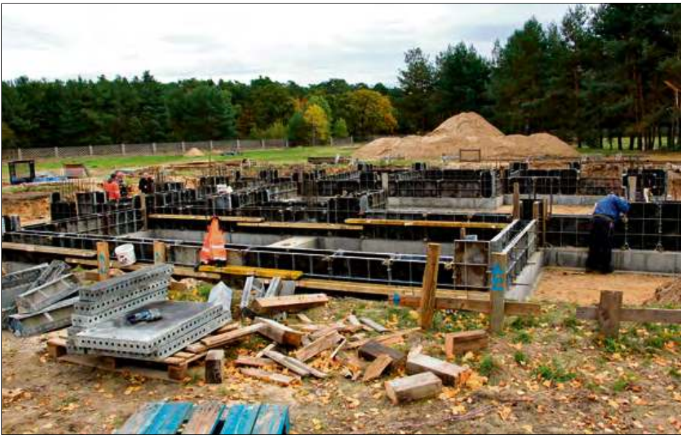
Zakończył się etap budowy fundamentów kaplicy.
