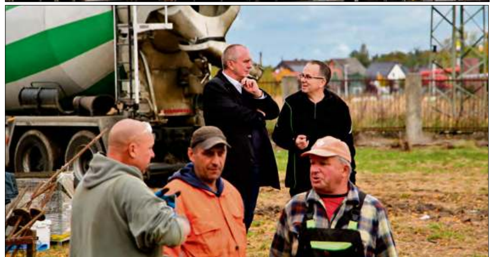
Postęp prac sprawdzali burmistrz Andrzej Kasiura i kierownik Biura Inwestycji Gminnych Zbigniew Bahryj.
