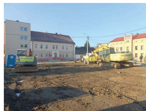
Prace związane z rewitalizacją skweru rozpoczęły się pod koniec ubiegłego roku
