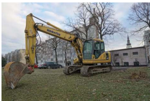
Na plantach przy ul. Pocztowej pojawił się już ciężki sprzęt do prac ziemnych. Fot. UMIG Strzelin
