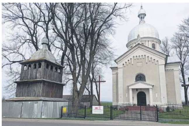
Kompleksowe prace przy remoncie dzwonnicy w Szczepiatynie obejmują wymianę podwalin, słupów konstrukcyjnych i deskowania, naprawę kopuły i latarenki. Te pierwsze zrobiono w ub. roku.
