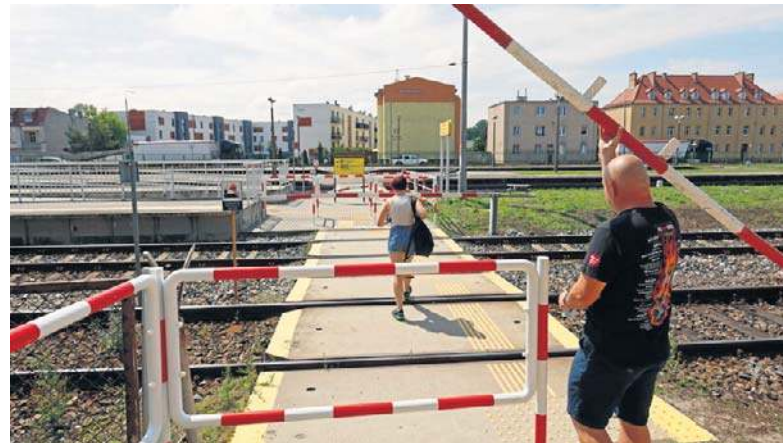
Tymczasowe przejście na perony dworca. Niepełnosprawni, aby otwarto im szlaban powinni dzwonić pod nr 571 339 458
