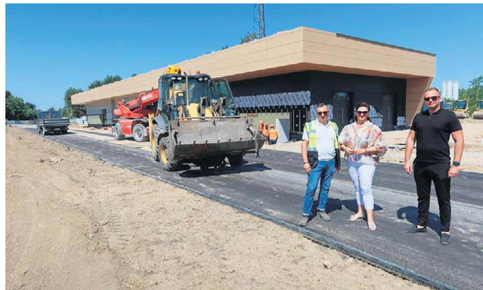
Budowa kompleksu wkracza w etap prac wykończeniowych
