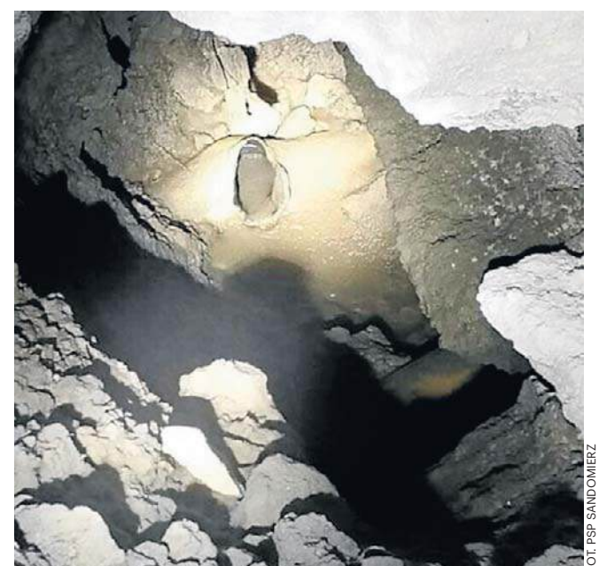
Strażacy dostali sygnał o prawdopodobnym ulatnianiu się gazu na stacji benzynowej w Zawichoście
