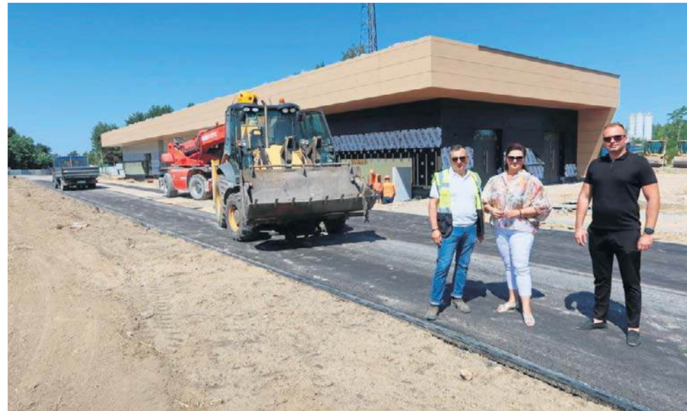
Budowa kompleksu wkracza w etap prac wykończeniowych
