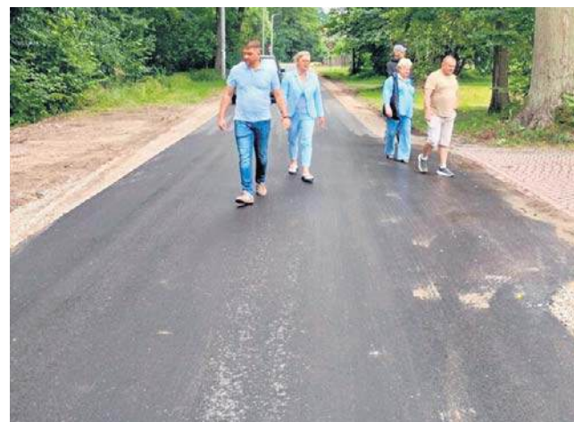
Ulica Spacerowa w Masłowie Pierwszym zyskała nową nawierzchnię asfaltową
