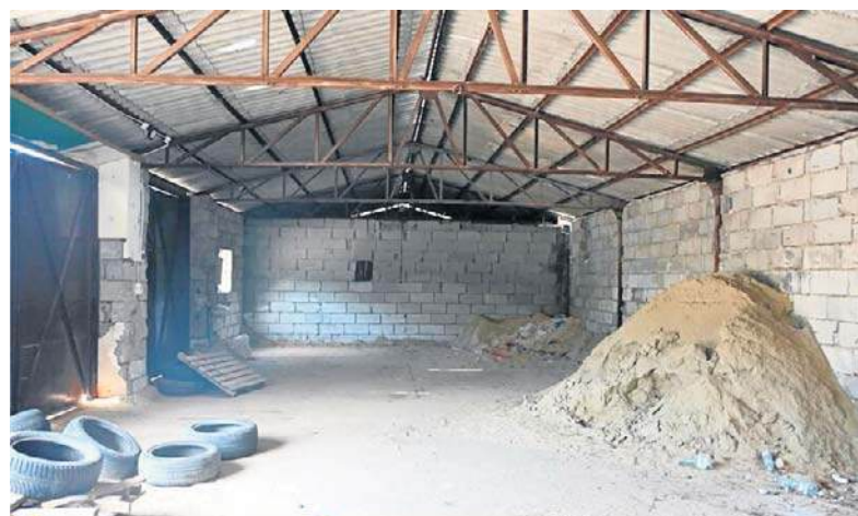
Na potrzeby magazynu ochrony ludności będzie wyremontowany budynek na terenie Powiatowego Zarządu Dróg w Białobrzegach.
