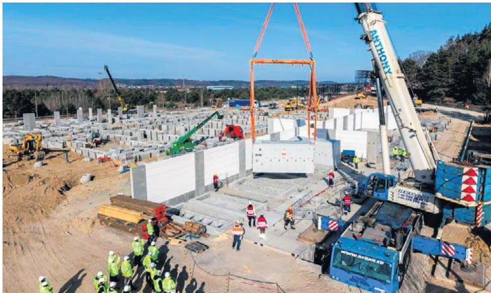
Montaż elementów magazynowania energii w technologii DC-Link LG Energy Solution
