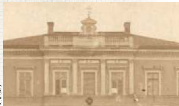
W okresie, kiedy w Pałacu na piętrze była cerkiew, dorobiono też niewielką, znajdującą się nad świątynią bizantyjską kopułę
