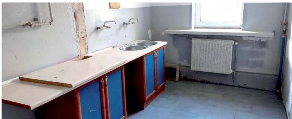
Nowa siedziba wymagała remontu. Koło Gospodyń Wiejskich większość prac już wykonało. W trakcie remontu kuchnia
