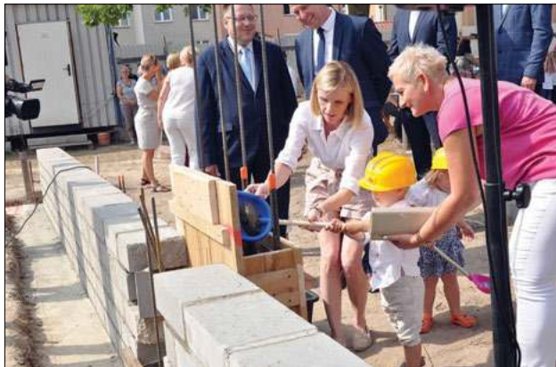
Położono kamień węgielny pod budowę żłobka i przedszkola w Międzyrzecu Podlaskim
