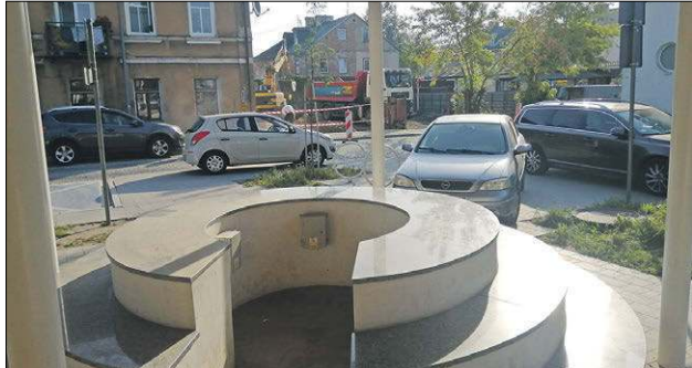
Prace wyburzeniowe już się zakończyły, a firma Żwir-Bud, która wykonuje zlecenie za 150 tys. zł, w ramach umowy ma teraz dokonać utwardzenia całej działki (na zdj. w tle)
