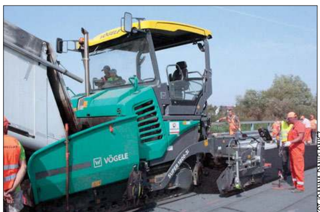
Krzyś miał okazję osobiście sprawdzić, jak pracują wielkie maszyny na budowie, jeżdżąc z operatorem w kabinie jednej z nich
