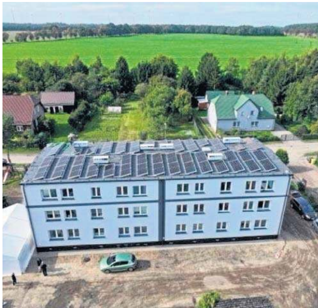
W budynku docieplony został dach, ściany zewnętrzne i fundamenty, wymieniono drzwi i okna.
