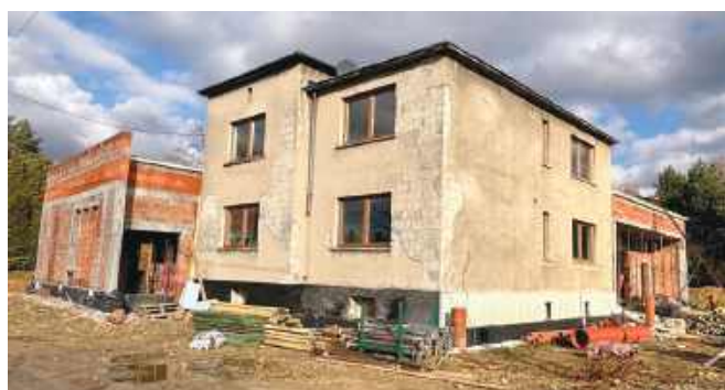
■ Nowa siedziba w budowie
