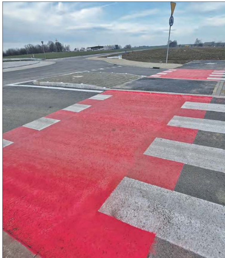
Nowa infrastruktura drogowa w strefie przemysłowej w Prudniku
