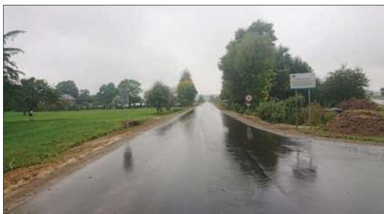
▲ Przebudowa drogi gminnej
