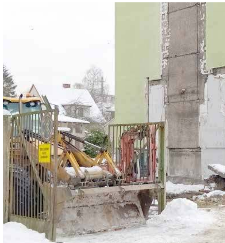
Trwają prace przy ul. Zielonej. Na początku trwało wyburzanie części pozostałości kotłowni
