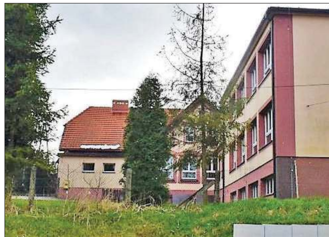
Sala gimnastyczna zostanie wybudowana z tyłu szkoły
