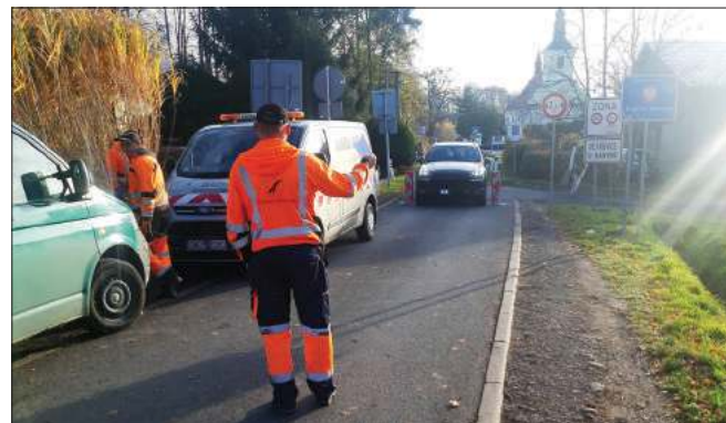
Rankiem 5 listopada pracownicy PZD rozpoczęli montaż trzech słupków, które uniemożliwiają obecnie samochodom przejazd przez przejście graniczne
