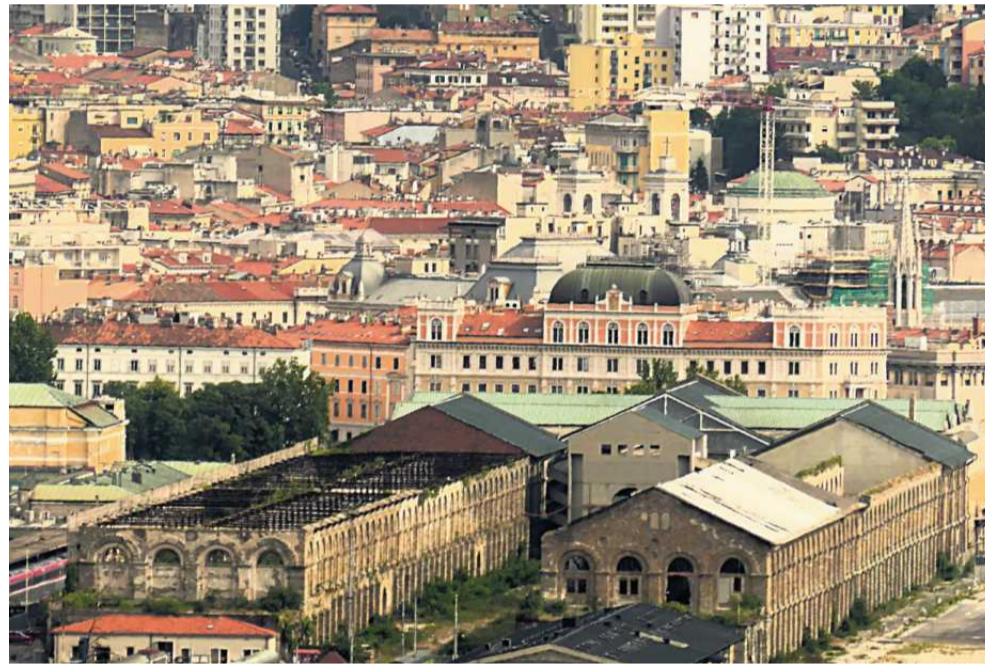
• Trieste. Na pierwszym planie opuszczone po wojnie budynki starego portu, w których szukają schronienia uchodźcy z Azji. Ten bez dachu nazywają „Silosem”
