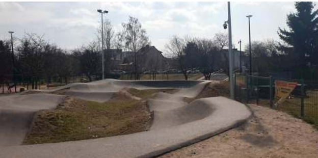
Latarnie stoją zaledwie półtora metra od toru i ich zabezpieczenie jest rozsądnym rozwiązaniem
