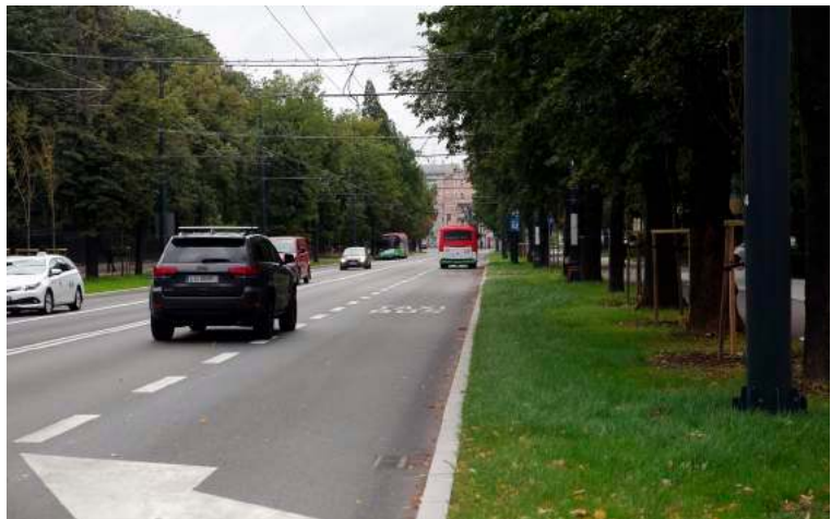
Przebudowa Alei Racławickich wraz z ul. Lipową i Poniatowskiego trwała od kwietnia 2020 roku do sierpnia 2021 roku. Kosztowała ponad 100 mln zł, z czego 85% stanowiło unijne dofinansowanie. Wykonawcą prac było konsorcjum firm: Przedsiębiorstwo Robót Drogowych Lubartów oraz Komunalne Przedsiębiorstwo Robót Drogowych z Lublina
