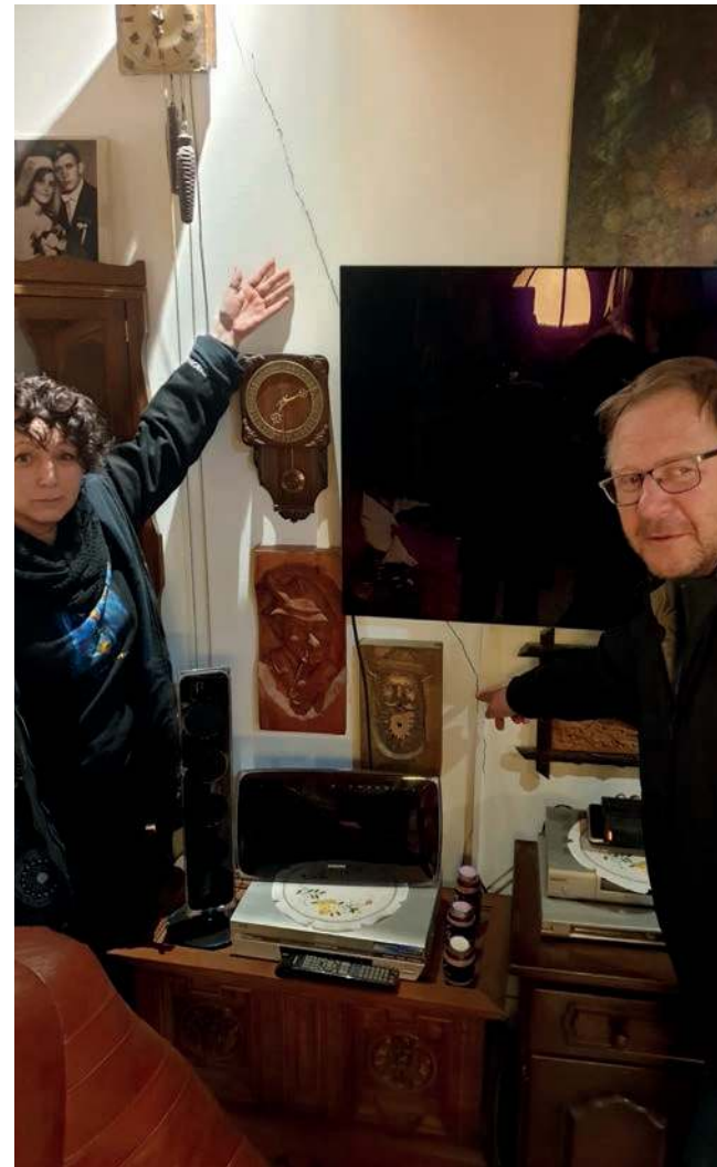
Dorota Dyba i Michał Potempa przy pękniętej ścianie w jednym z domów na os. Borowiec w Chrzanowie
