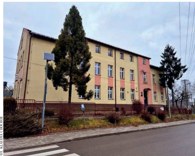
Szkoła w Paczółtowicach. Jej budynek w przyszłości ma służyć lokalnej społeczności
