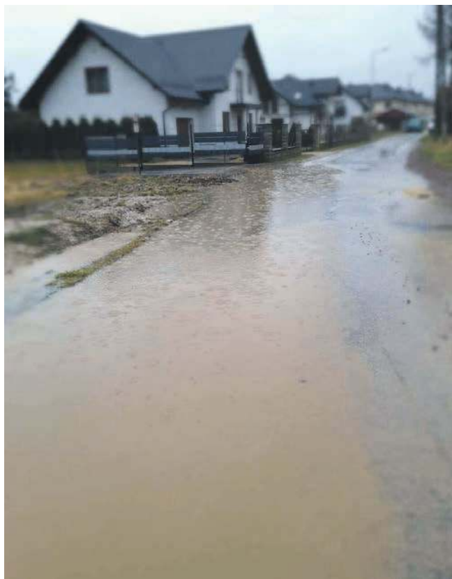
Zalana ulica Bandurskiego podczas ostatnich deszczy
