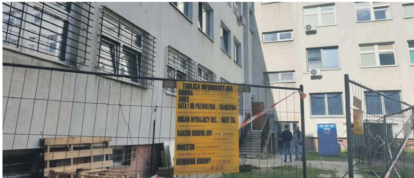
(ES) Pomieszczenia w budynku C szpitala zajmie wkrótce PCPR
