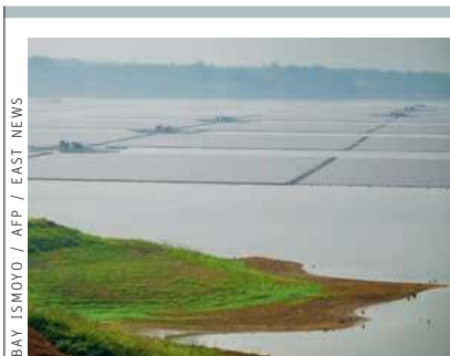
Pływak elektrownia słoneczna. Zbiornik Cirata na Jawie Zachodniej, 9 listopada 2023 r.
