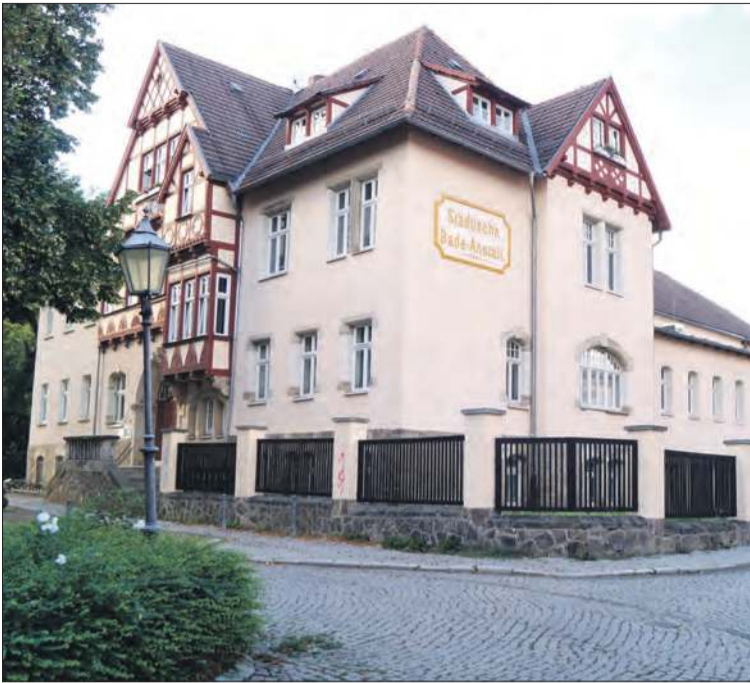
Bryła budynków w Prudniku i Quedlinburgu jest niemal identyczna. Różnią się w wykonaniu detali elewacji.
