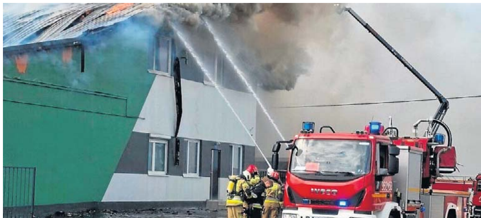
W kwietniu 2026 pożar objął halę produkcyjno-magazynowo-biurową firmy w Dziardonicach w gminie Kowal. Straty są ogromne
