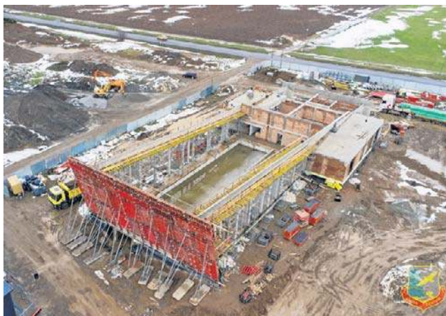
Budowa basenu w Sękowej. Skalę inwestycji i postęp prac najlepiej widać z lotu ptaka
