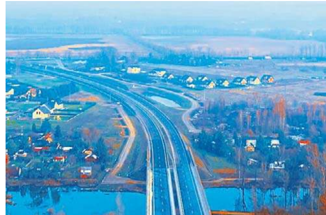
Obecnie gotowe są już trzy odcinki 9-kilometrowej obwodnicy Oświęcimia
