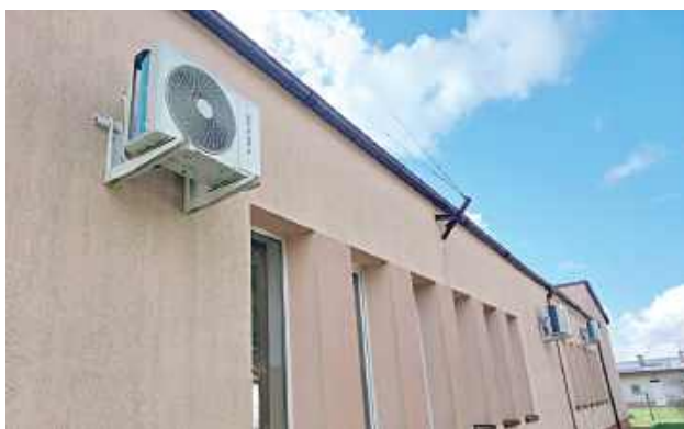
Modernizacja została przeprowadzona z myślą o poprawie warunków użytkowania sali, która służy mieszkańcom jako miejsce spotkań, wydarzeń i działalności społecznej. Dzięki nowej instalacji przestrzeń stała się bardziej funkcjonalna i komfortowa – szczególnie w okresie letnim
