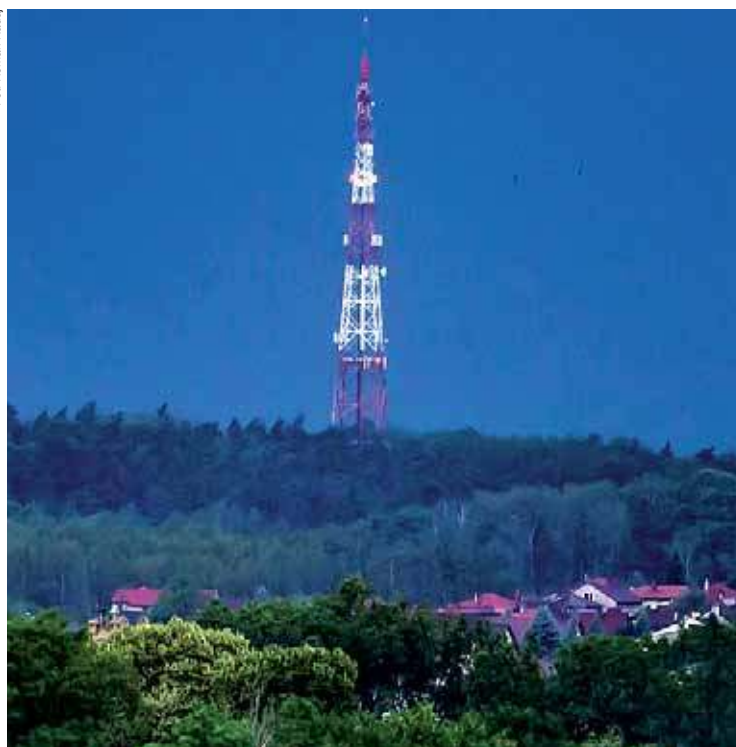
W tej części Ciechanowa stoi już jeden potężny maszt - górujący nad okolicą
