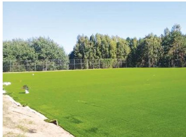
Powstała już sztuczna nawierzchnia i oświetlenie.
