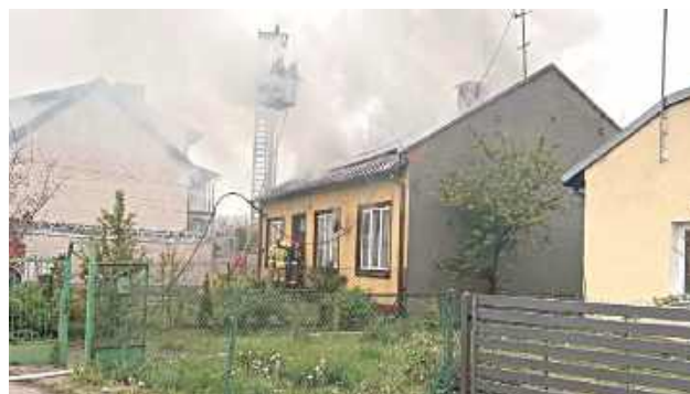
Ogień objął drewniany budynek mieszkalny pokryty blachą. Na miejsce skierowano liczne siły straży pożarnej
