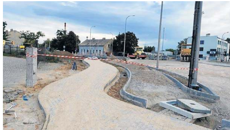
Przy Powiatowym Urzędzie Pracy we Włocławku zamiast sygnalizacji świetlnej będzie rondo turbinowe
