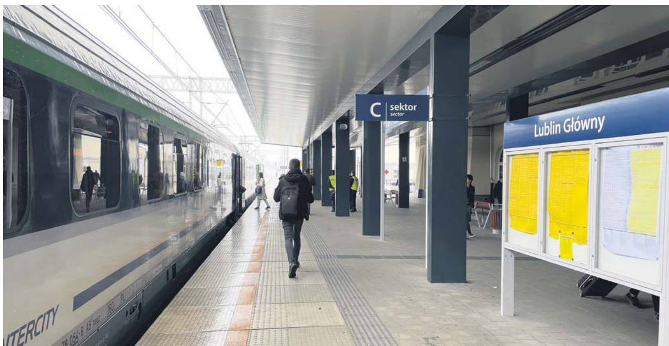
Przebudowana stacja Lublin Główny zapewnia dostęp do kolei wszystkim podróżnym
