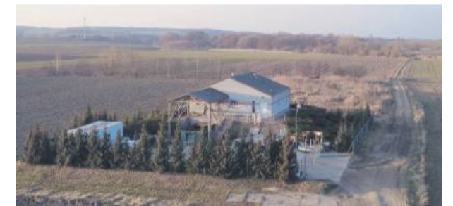
Otrzymane dofinansowanie pozwoli m.in. na usprawnienie oczyszczalni ścieków w Przewornie
