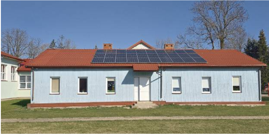
Budynek zabytkowej części szkoły
