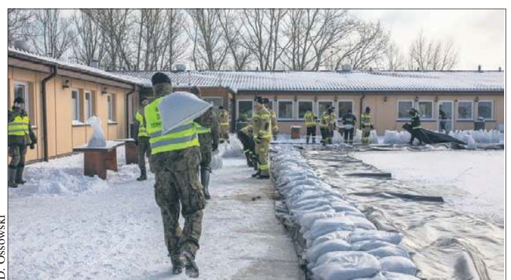
Żołnierze i strażacy zabezpieczali obiekty nad Wisłą
