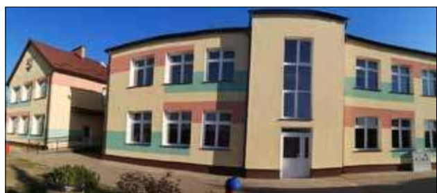
Budynek Zespołu Szkół w Sławatyczach został ocieplony, założono w nim też instalację fotowoltaiczną oraz wymieniono okna
