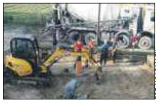
Koszt przebudowy oczyszczalni ścieków to 1,6 mln zł
