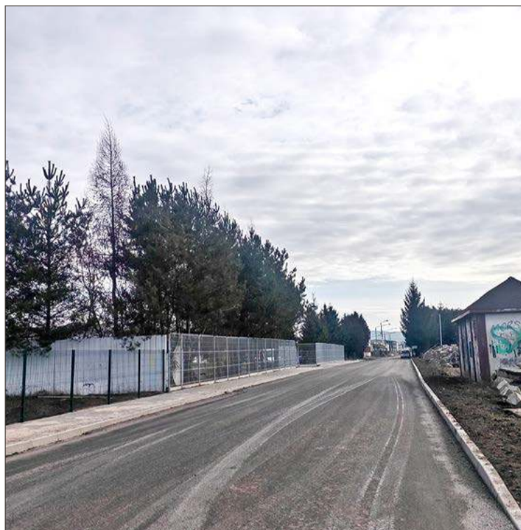
Remont tego odcinka kosztował ponad 2 mln zł.
