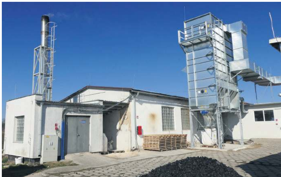
W miejsce obecnej kotłowni ma powstać nowa
