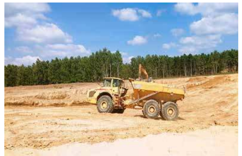
Koniec prac zapowiedziany jest na koniec 2021 r.
