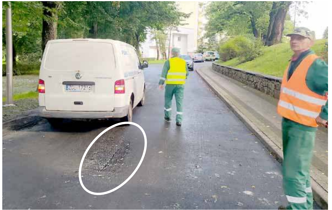
Na miejscu, przed godz. 9 przybyli pracownicy PUWiSu
