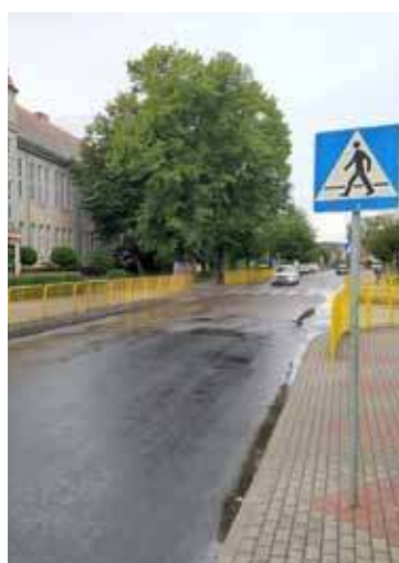
Do wykonania są m.in. pasy, gdzie w tym roku położona została nowa nawierzchnia. Na zdjęciu ul. Wojska Polskiego
