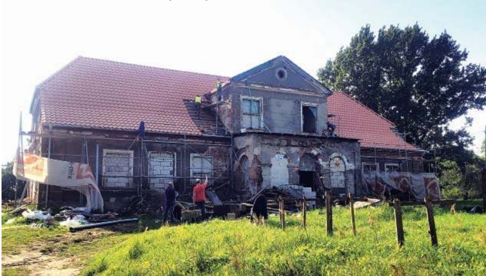
Dworek Beliana w trakcie wymiany dachu
