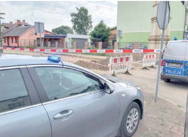
Znalezisko zostało zabezpieczone. Prawdopodobnie w miejscu prac w XIII-XVIII wieku znajdował się cmentarz przykościelny, na co wskazują wyraźne zarysy grobów
