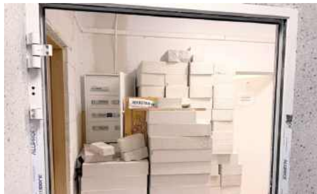
Remont w Milejowie - dojście do sekretariatu
