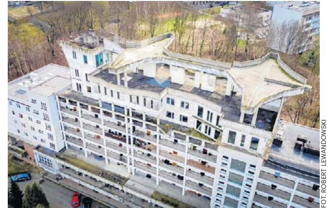
Część nadbudowy została już rozebrana
