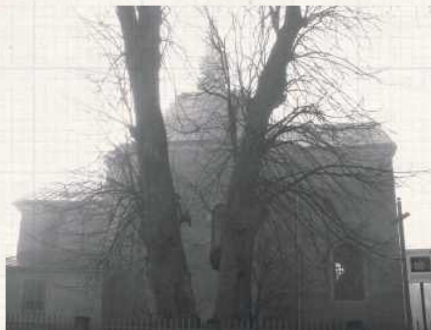
Kościół pw. Opieki św. Józefa w Cycowie zbudowany został ok. 1860 roku jako świątynia grekokatolicka pw. Michała Archanioła. W 1875 został przejęty przez administrację carską i przekazany duchowieństwu prawosławnemu. W 1915 roku został pozostawiony bez opieki. W kolejnych latach służył jako świątynia rzymskokatolicka. Zdjęcie z karty zabytku na stronie https://zabytek.pl/
